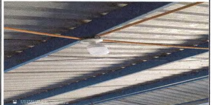
Foto 12: Sustitución de lámparas tipo LED en todos los módulos.
