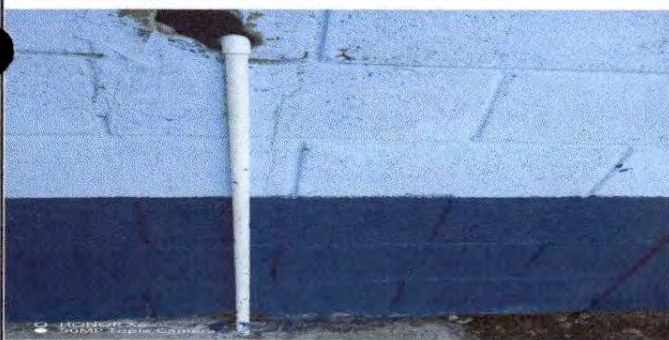
Foto 11: Sustitución de tubería PVC de línea principal aguas negras en los baños.
