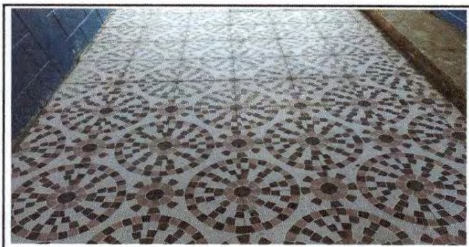
Foto 6: Sustrucion de piso de torta de concreto por Piso cerámico en el pasillo del establecimiento.
