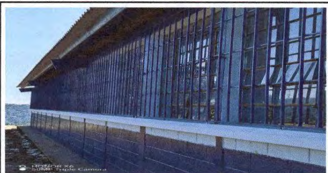
Foto 3: sustitucion de vidrios y mantenimiento a balcones de metal de la parte exterior de todo el establecimiento.
