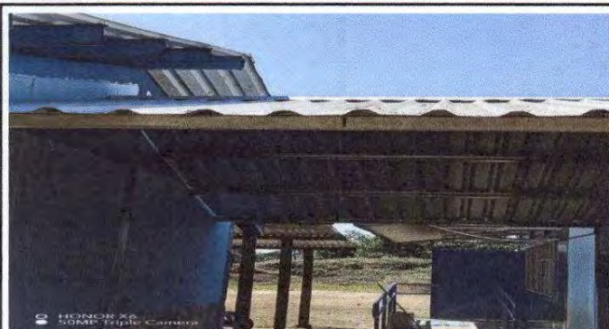
Foto1: Sustrucion de Lámina por lámina troquelada Aluzinc calibre 26 en el pasillo.
