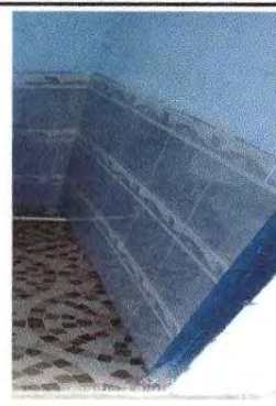
Foto 10: Sustitución de tabique por azulejo en los baños.
