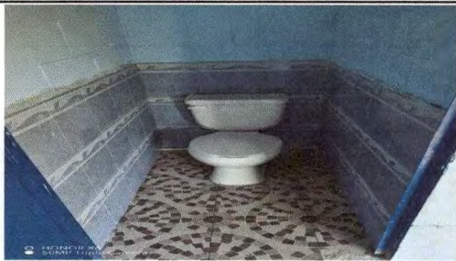
Foto 9: Sustitución de inodoro del baño.
