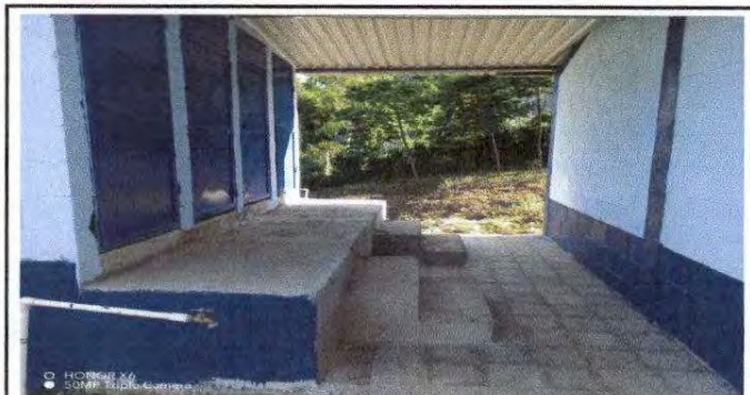
Foto 4: Reparacion del piso de torta de concreto de los Baños.
