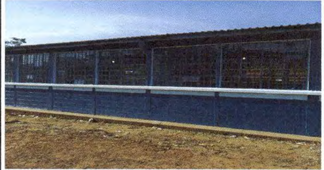
Foto 8: Pintura en muros exteriores del establecimiento.
