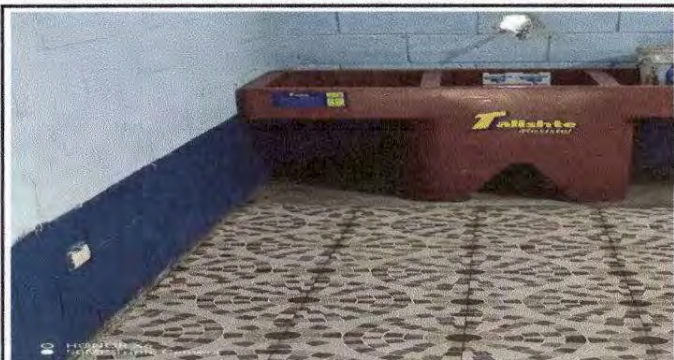
Foto 13: Instalacion de pila de plastico de dos lavaderos en la cocina.
