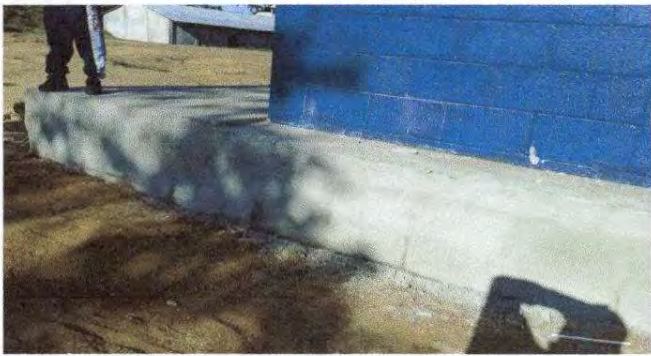
Foto7: Reparación de cuneta de concreto del lado derecho del establecimiento.
